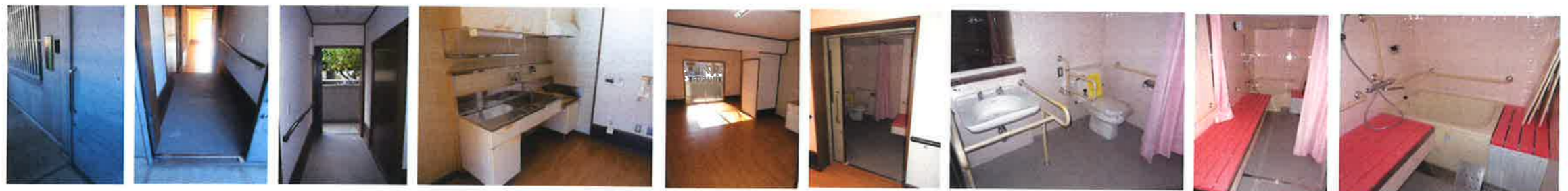
玄関引き戸 玄関スロープ 玄関手摺 流し台回り LDK 水回り入口扉 洗面~便所回り 浴室回り 浴槽回り
